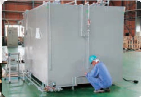
電気配線・配管
