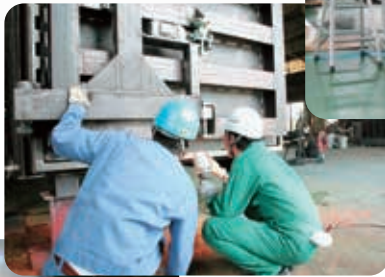
労働局による缶体検査
